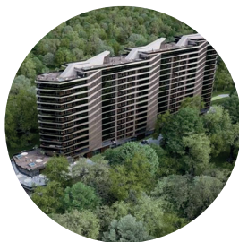
Rezidenční komplex “Green Wood”, Odesa
