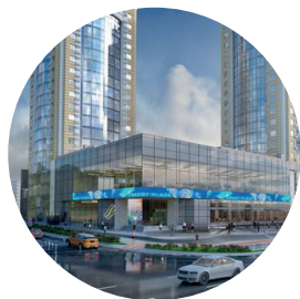
Rezidenční komplex “Smart Plaza Polytech”, Kyiv
